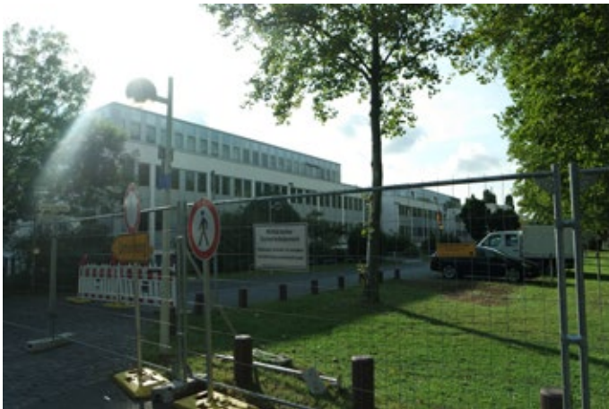
Das im Aufbau befindliche Kommando CIR in Bonn von vorne...
