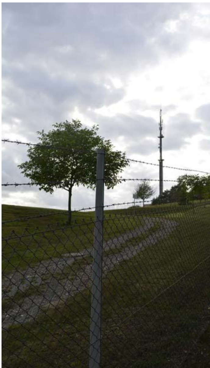
Bis 2020 soll die Kaserne mit umfangreicher IT und Fernmeldetechnik ausgestattet werden. Quelle: IMI
