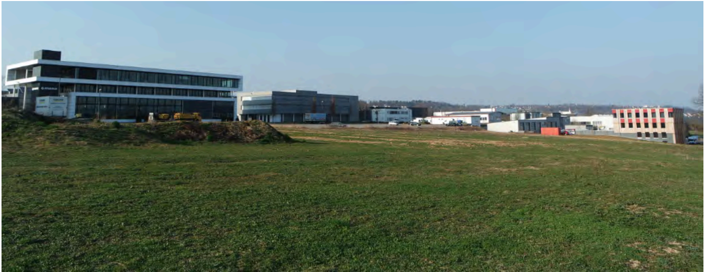
Fläche in Kirchentellinsfurt auf der eine Produktion von Hochleistungs-Akkus u.a. für Drohnen entstehen soll, Foto: Privat.
