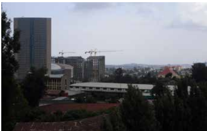
Baustelle für das AU-Konferenzgebäude 2012. Quelle: Elmschrat Coaching-Blog, via Wikimedia Commons
