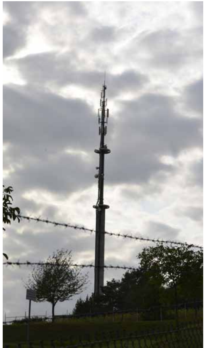
An ein Militärgelände angrenzender Sendemast in Hartheim. Quelle: IMI
