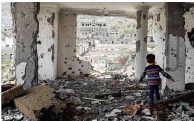
Kind in einem durch Luftangriffe zerstörten Gebäude in Taizz, Jemen. Quelle: Felton Davis / Flickr
